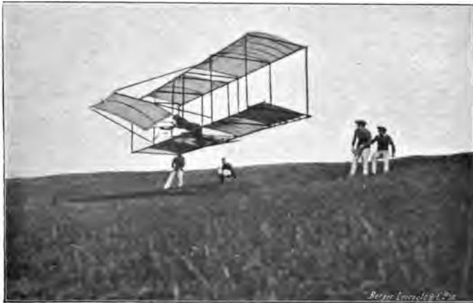
Fig. 41. — Aéroplane n° 5. — Le gouvernail est mal tenu.
